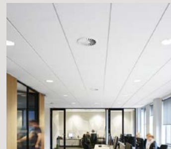
Installationsstråk i mittkärna. Nedpendlat undertak, synligt bärverk.
