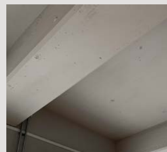
Övrigt tak: Synligt bjälklag i befintligt skick.
